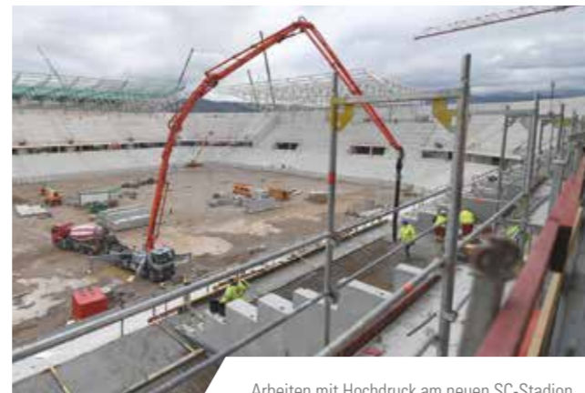
Arbeiten mit Hochdruck am neuen SC-Stadion
