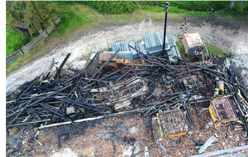
Dreschhalle bei Lörrach: Trotz schneller Reaktion der Anwohner und Einsatzkräfte kam es zum Totalschaden.
